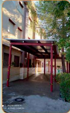
Ampliación del porche en edificio de primaria, CEIP El Pinar
