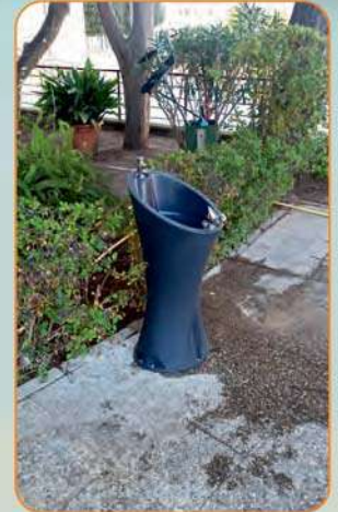
Instalación de fuente CEIP El Pinar
