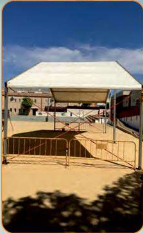
Instalación de carpa en patio CEIP El Pinar
