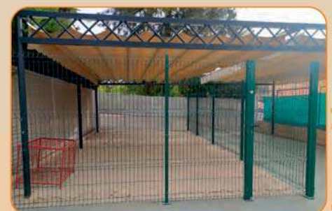
Instalación de arenero con valla perimetral CEIP Ana Josefa Mateos
