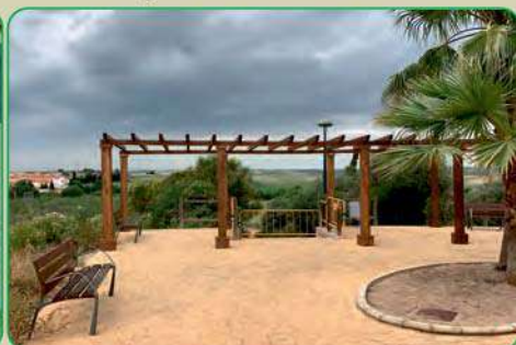
Arreglo de pérgola parque Vicente Ferrer
