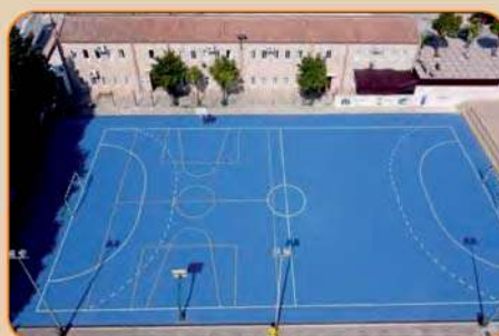
Tratamiento, reparación y rehabilitación de pista deportiva CEIP El Pinar
