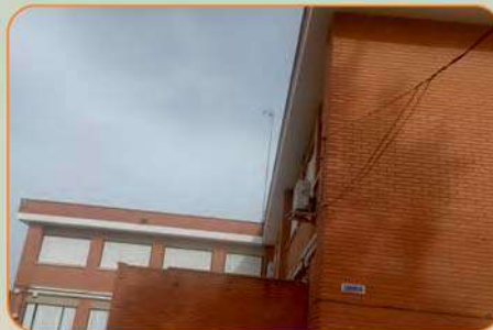
Reparación de cornisa perimetral CEIP Antonio Gala
