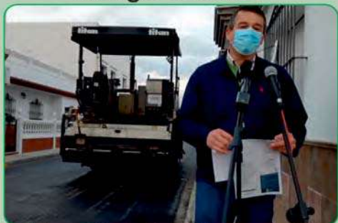
Adecuación de vías públicas con cargo al superávit municipal
