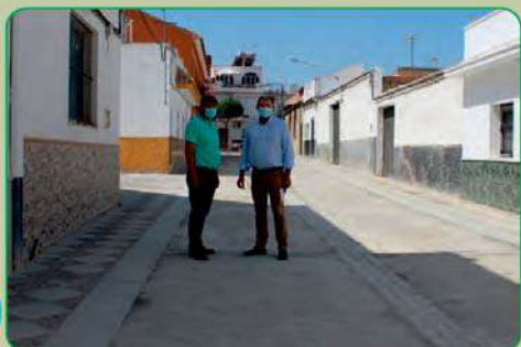
Obras reurbanización calle Correos
