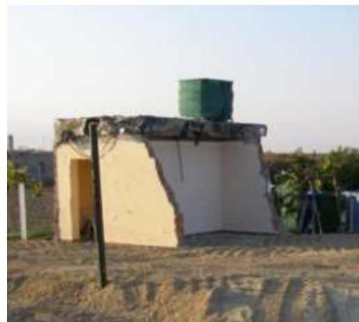
Restos de la construcción demolida
